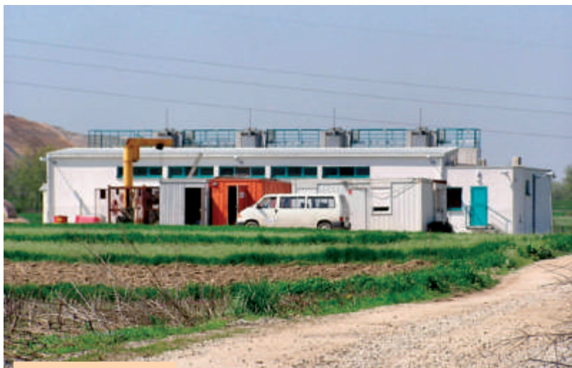
Ilustracija 9 Objekt za demanganizaciju na crpilištu Petruševac
