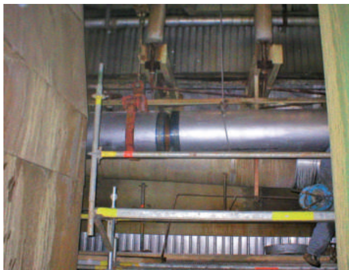
Ilustracija 1 Nekoliko detalja izvođenja radova na zamjeni parovoda vruće međupregrijane pare glavnog kotla
