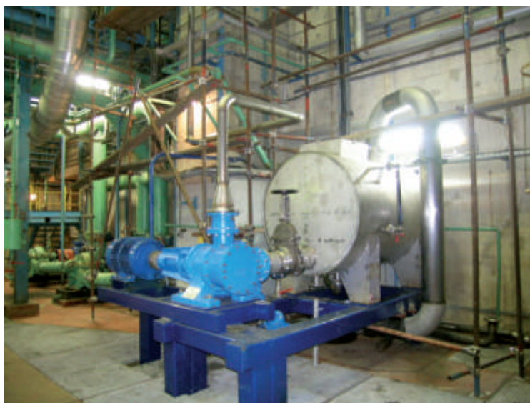
Ilustracija 4 Nova vakuumska stanica rashladne morske vode
