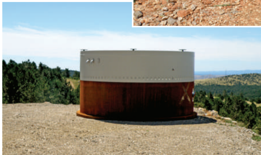
Ilustracija 12 ... i jedan od temeljnih djelova stupa vjetroturbine
