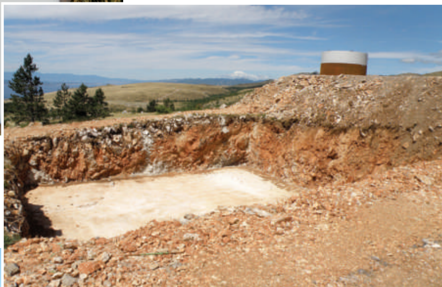
Ilustracija 11 Pogled na iskop i betoniranu temeljnu jamu...
