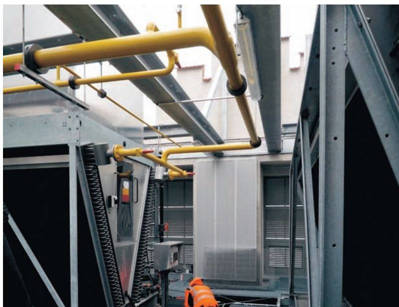
Ilustracija 4 Hibridni kondenzatori smješteni u potkrovlju zgrade u kojoj se nalazi strojarnica...
