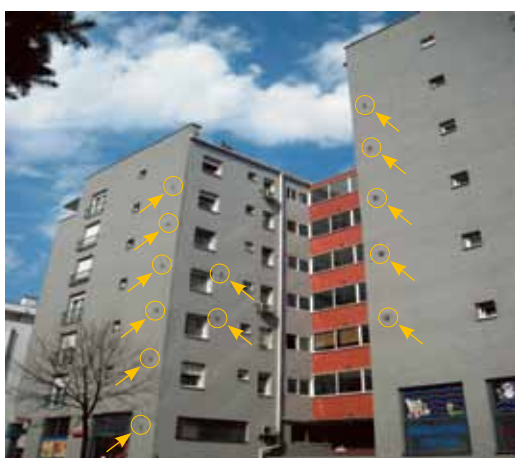
Ilustracija 1 Primjeri 'zanimljivih' 'rješenja' za odvod dimnih plinova iz plinskih uređaja u (novoizgrađenim!) zgradama na području Zagreba (dodatni komentar nije potreban, zar ne?)
