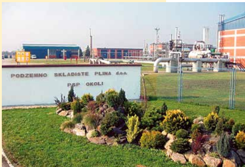
Podzemno skladište plina d.o.o., Zagreb
