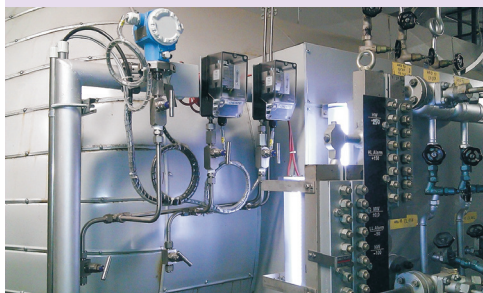
Mjerenje tlaka u bubnju
