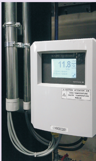
Mjerenje udjela kisika u dimnim plinovima
