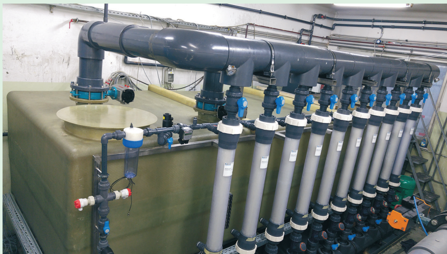
... i ugrađeno ultrafiltracijsko postrojenje u tvornici LTH Castings u Ljubljani
