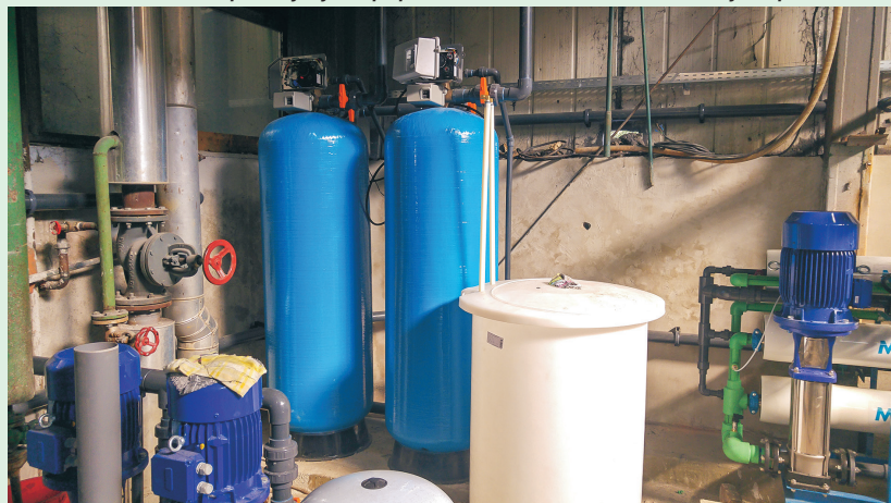
... i ionski omekšivači u postrojenju za pripremu kotlovske vode u Tvornici ulja Čepin
