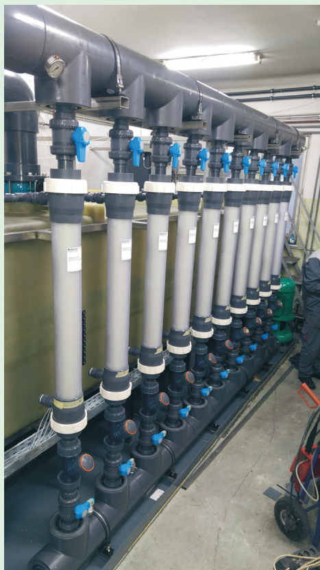
... i ugrađeno ultrafiltracijsko postrojenje u tvornici LTH Castings u Ljubljani
