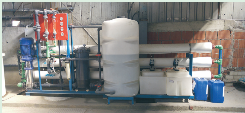
... i ionski omekšivači u postrojenju za pripremu kotlovske vode u Tvornici ulja Čepin
