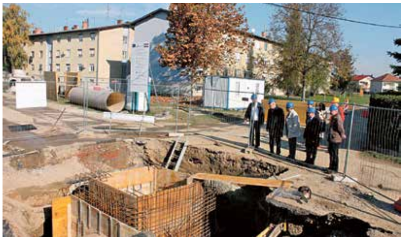
▲ Gradnja sustava odvodnje ...
