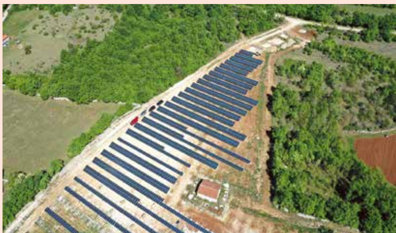
▲... i na gradilište SE Marići
