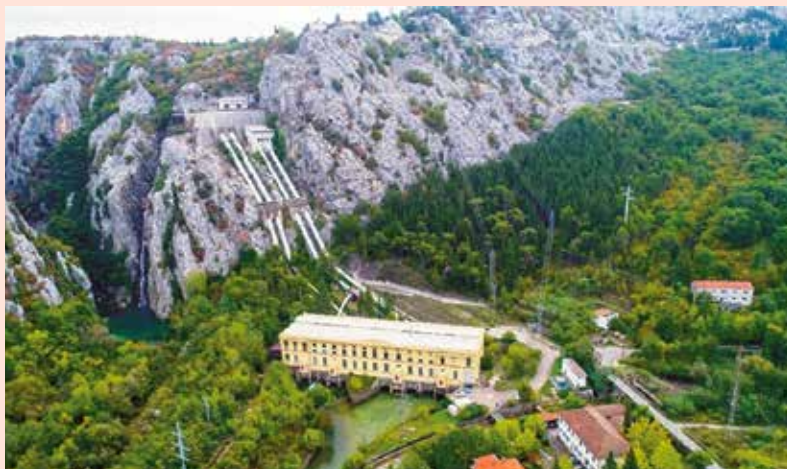
▼ Srojarnica, tlačni cjevovodi i dio kanjona Cetine
