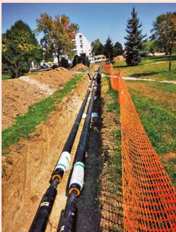
◀ Ilustracija 1 Izgradnja toplovoda u Velikoj Gorici
