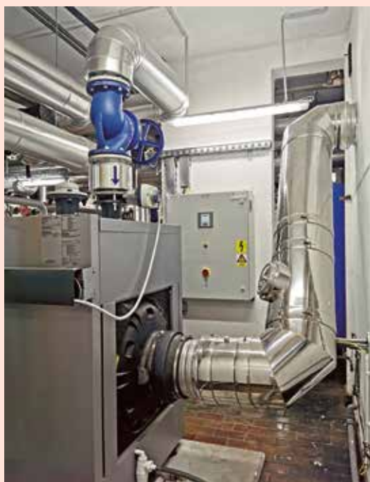
► Ilustracija 4 Rekonstrukcija kotlovnice Remetinečki gaj 27b u Zagrebu
