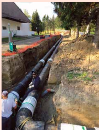
▲ Ilustracija 8 Izgradnja novog magistralnog vrelovoda
