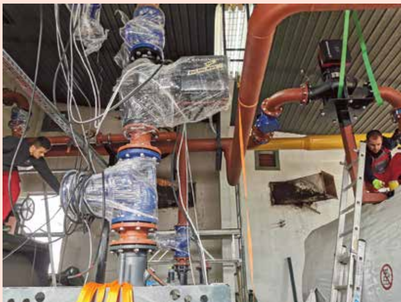
▲ Ilustracija 3 Rekonstrukcija kotlovnice Mokrička 61 u Zaprešiću
