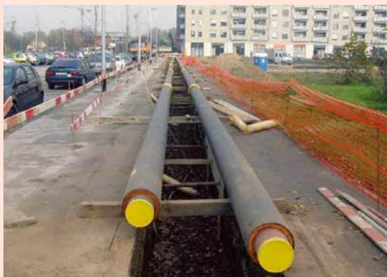
▼ Ilustracija 9 Predizolirane cijevi prije polaganja u pripremljeni iskop
