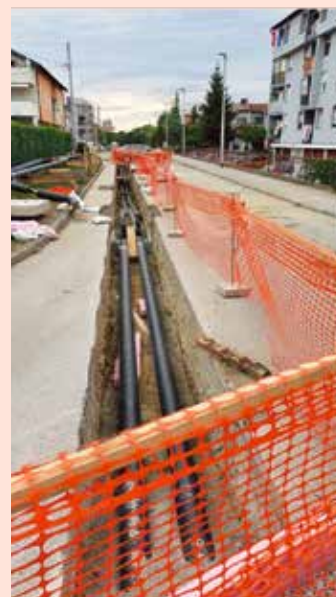
▶ Ilustracija 6 Izgradnja vrelovoda u Zaprešiću
