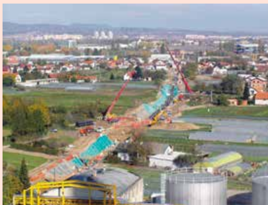
▶▶ Ilustracija 2 Radovi na dionici D1, faza 1
