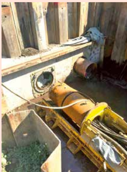
▶▶ Ilustracija 3 Radovi na tuneliranju na dionici D2, faza 4
