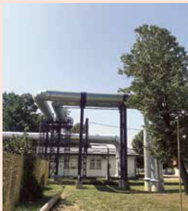
◀▶ Ilustracija 1 Izgrađeni vrelovod dionice D0
